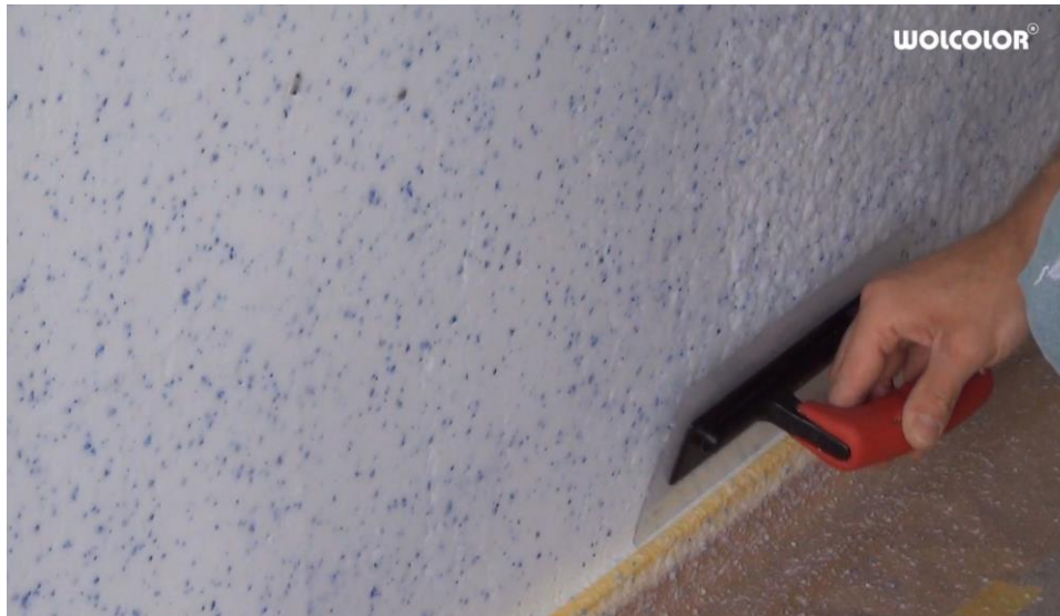
Abb: Rechts sehen Sie die grob vorgesprühte Wand, links die geglättete Oberfläche.
